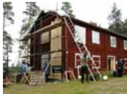
Byggnadsvård på Hille hembygds gård.
